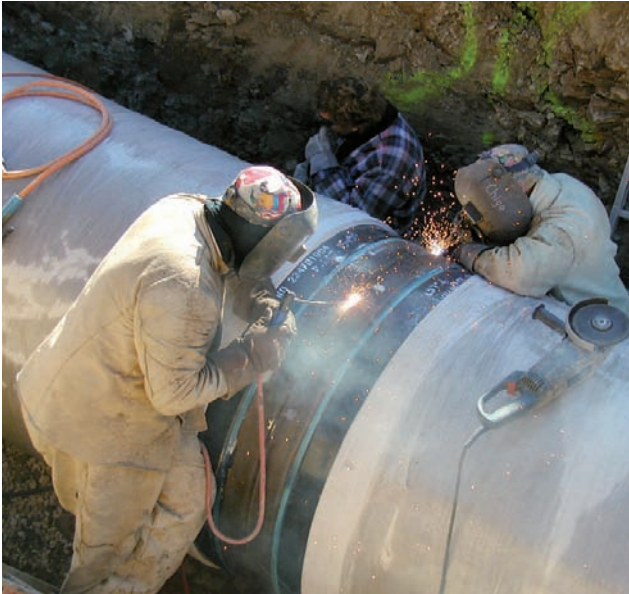
Abb. 3 Schweißen einer Stahlrohrleitung DN 1.200
