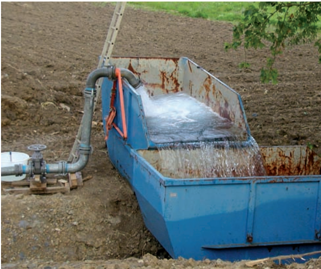
Abb. 5 Spülen der Leitung am Tiefpunkt (Brunnenalter > 30 Jahre)
