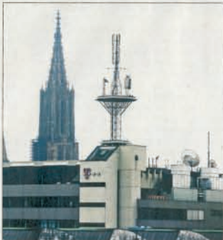
Bakterienbruststätte: Das Telekomgebäude samt Kühlaggregaten
