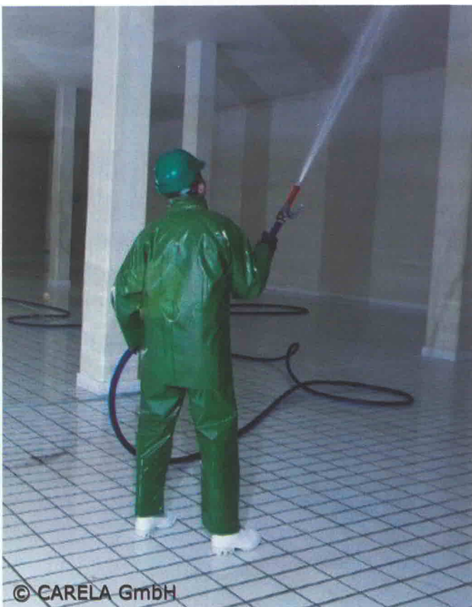
Bild 1: Die richtige persönliche Schutzausrüstung ist ein wichtiger Bestandteil der Hygienestrategie, denn sie trägt entscheidend dazu bei, dass während der Reinigung keine zusätzlichen Verunreinigungen von außen in den Behälter getragen werden. Dazu zählen weiße, lebensmitteltaugliche Schutzstiefel, wasser- und chemikalienabweisende Schutzkleidung und Handschuhe, sowie ein Schutzhelm ggf. mit Augenschutz
