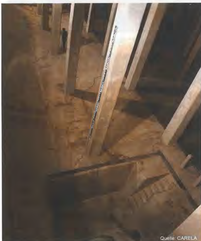
Reinigung eines Trinkwasserbehälters
