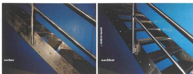
Bild 4: Die fachgerechte Reinigung vorhandener Zugänge zur Wasserkammer ist ebenfalls wichtiger Bestandteil hygienischen Risikomanagements in Trinkwasserbehältern.
