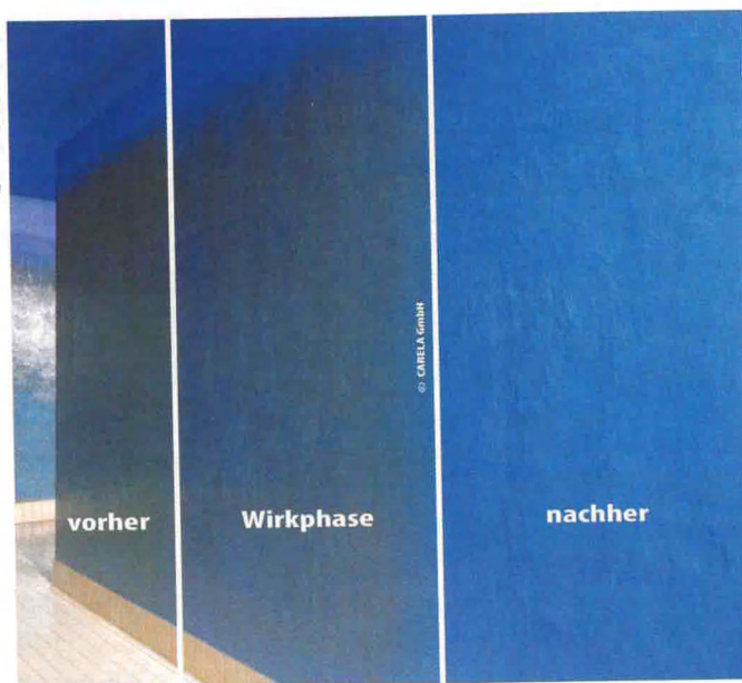
Bild 3: Eine fachmännische Reinigung entfernt Biofilme und andere Beläge von den Oberflächen im Trinkwasserbehälter effektiv.
